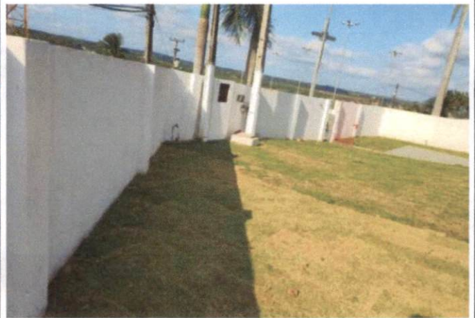
(Item 9.4) CAIAÇÃO BRANCA EM PAREDES EXTERNAS
