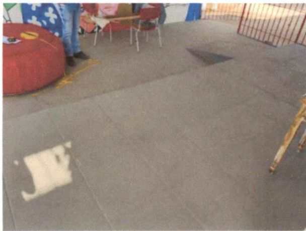
(Item 9.1) PINTURA DE PISO COM TINTA ACRÍLICA
