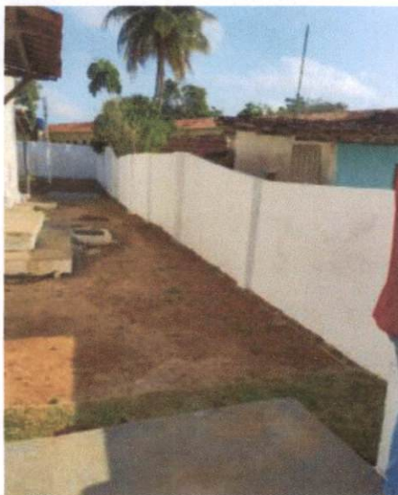
(Item 9.4) CAIAÇÃO BRANCA EM PAREDES EXTERNAS
