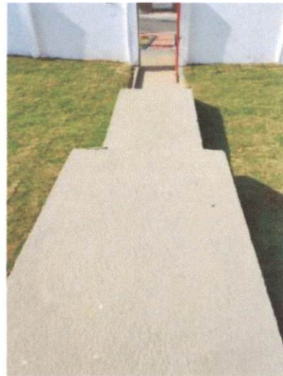
(Item 9.1) PINTURA DE PISO COM TINTA ACRÍLICA
