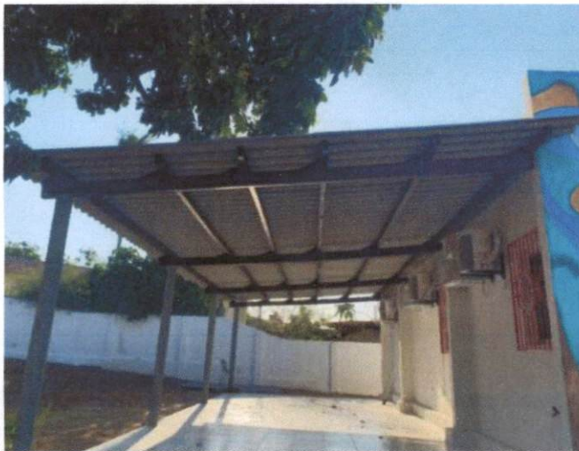
(Item 9.2) TELHAMENTO COM TELHA DE FIBROCIMENTO, (Item 9.3) TRAMA DE MADEIRA (Item 9.5) PINTURA VERNIZ
