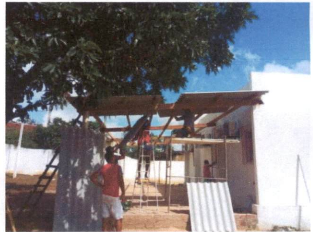
(Item 9.2) TELHAMENTO COM TELHA DE FIBROCIMENTO
