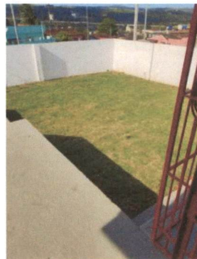
(Item 9.4) CAIAÇÃO BRANCA EM PAREDES EXTERNAS
