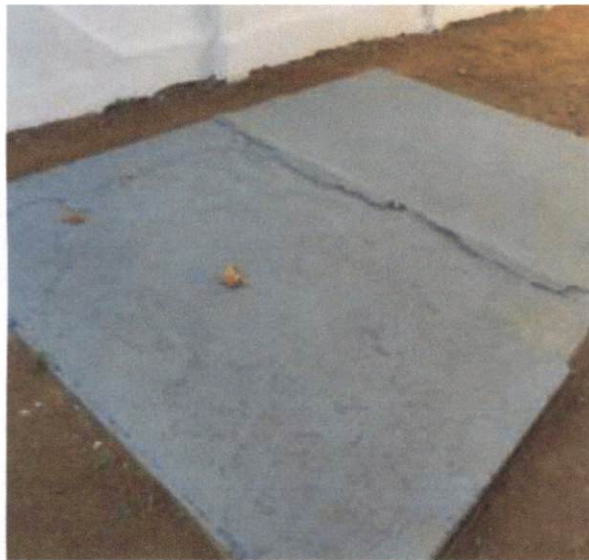
(Item 9.1) PINTURA DE PISO COM TINTA ACRÍLICA
