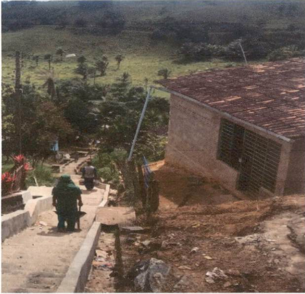
Item: 2.1 TRANSPORTE COM CARRO DE MAO DE AREIA, ENTULHO OU TERRA ATE 100M
