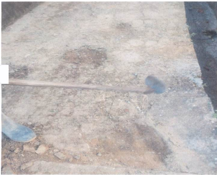
Item: 2.3 DEMOLICAO DE REVESTIMENTO DE PISO EM CIMENTADO
