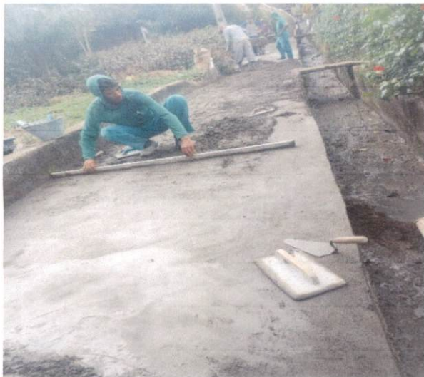
Item: 4.1 CONCRETO NAO ESTRUTURAL (1 4 8) PARA LASTROS DE PISOS E FUNDACOES, LANCADO E ADENSADO
