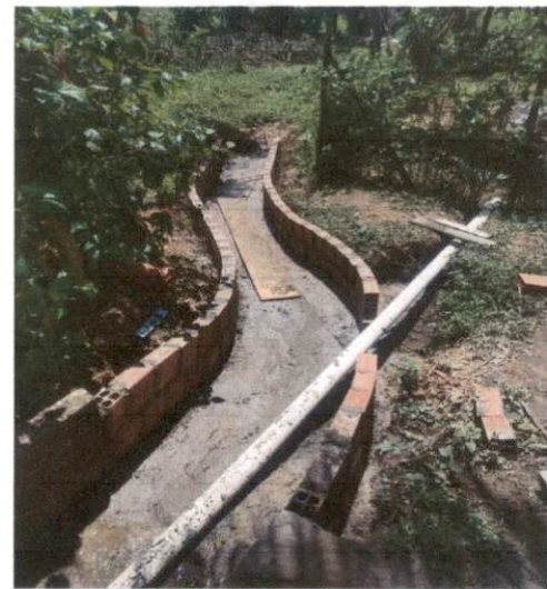
Item: 4.1 CONCRETO NAO ESTRUTURAL (1 4 8) PARA LASTROS DE PISOS E FUNDACOES, LANCADO E ADENSADO
