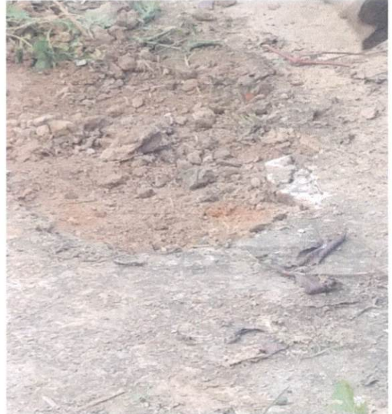
Item: 2.3 DEMOLICAO DE REVESTIMENTO DE PISO EM CIMENTADO
