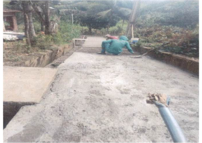
Item: 4.1 CONCRETO NAO ESTRUTURAL (1 4 8) PARA LASTROS DE PISOS E FUNDACOES, LANCADO E ADENSADO
