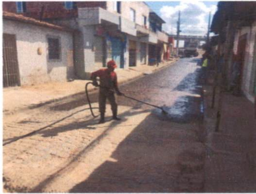
Item: 15.1.1 - EXECUÇÃO DE PINTURA DE LIGAÇÃO COM EMULSÃO ASFÁLTICA RR-2C – RUA 01- GUADALAJARA
