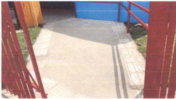
10.4 Rampa de acesso ao pátio coberto em concreto não-estrutural
