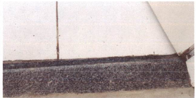
10.3 Soleira em granito cinza andorinha, L= 15cm, espessura 2cm
