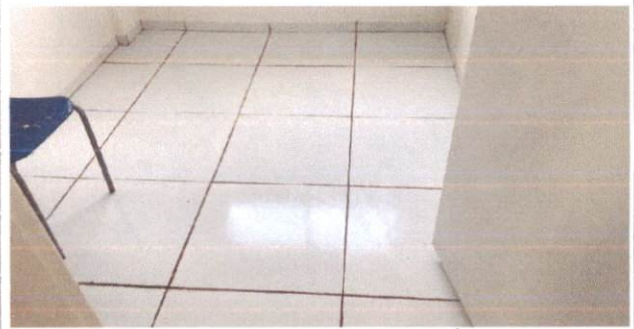
20.1 Limpeza de obra
