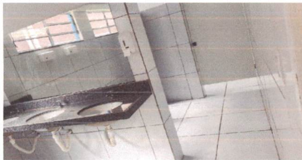
20.1 Limpeza de obra
