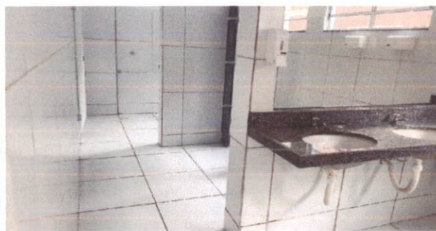
20.1 Limpeza de obra
