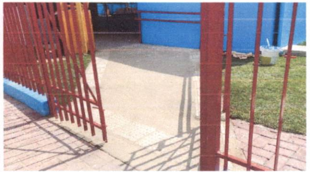
10.4 Rampa de acesso ao pátio coberto em concreto não-estrutural
