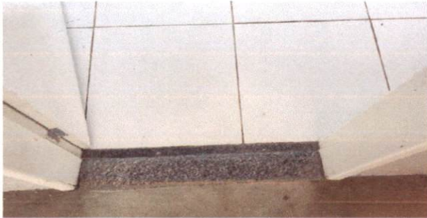
10.3 Soleira em granito cinza andorinha, L= 15cm, espessura 2cm
