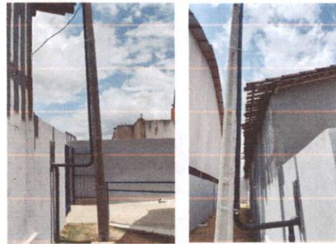
17.2.7 Eletroduto PVC rígido roscável Ø60mm (2")
