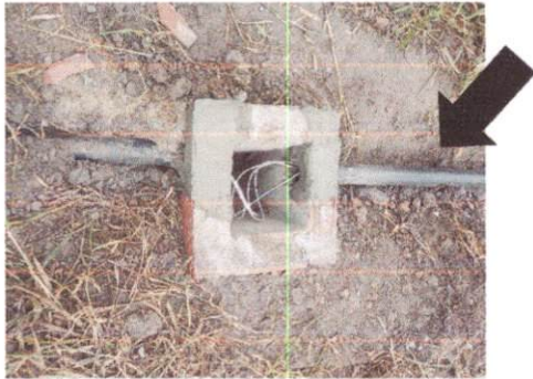
17.2.7 Eletroduto PVC rígido roscável Ø60mm (2")
