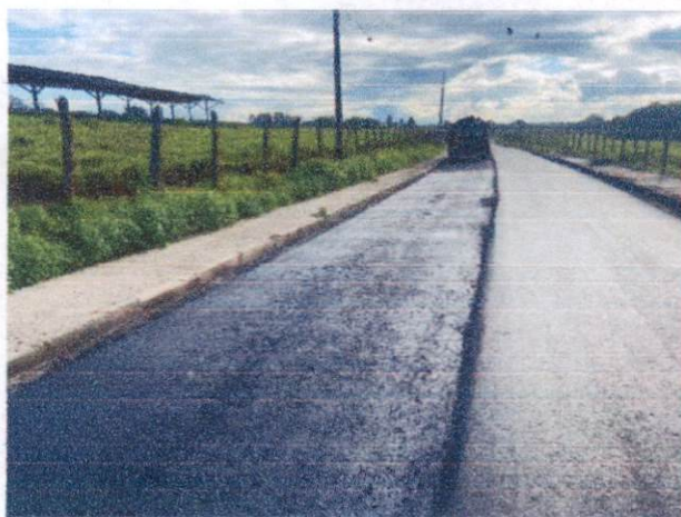
Item: 2.3.3 EXECUÇÃO DE PAVIMENTO COM APLICAÇÃO DE CONCRETO ASFÁLTICO, CAMADA DE ROLAMENTO - EXCLUSIVE CARGA E TRANSPORTE. AF_11/2019
