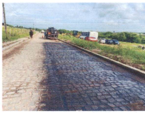
Item: 2.1.1 - EXECUÇÃO DE PINTURA DE LIGAÇÃO COM EMULSÃO ASFÁLTICA RR-2C. AF_11/2019
