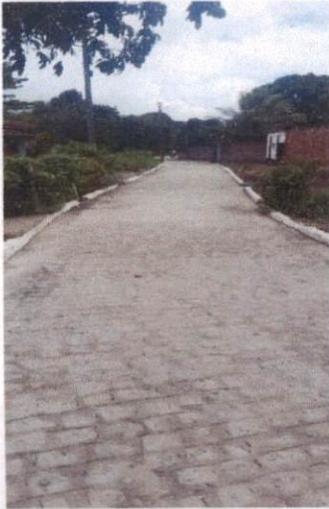
Descrição: RUA DOIS (CHÃ DE CONSELHO) – 30.1.1 EXECUÇÃO DE PAVIMENTAÇÃO EM PARALELEPÍEDOS, REJUNTAMENTO COM ARGAMASSA TRAÇO 1:3 (CIMENTO E ARREIA). AF_05/2020
