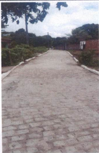
Descrição: RUA DOIS (CHÃ DE CONSELHO) – 30.1.1 EXECUÇÃO DE PAVIMENTAÇÃO EM PARALELEPÍPEDOS, REJUNTAMENTO COM ARGAMASSA TRAÇO 1:3 (CIMENTO E ARREIA). AF_05/2020
