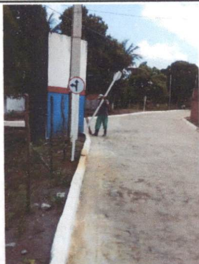
Descrição: RUA DA ESCOLA (CHÃ DE CONSELHO) – 24.3.1 FORNECIMENTO E IMPLANTAÇÃO DE REGULAMENTAÇÃO EM AÇO D = 0,60 M – PELÍCULA RETRORREFLETIVA TIPO I E SI
