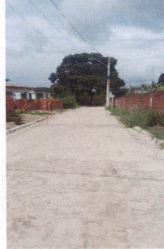
Descrição: RUA DOIS (CHÃ DE CONSELHO) – 30.1.1 EXECUÇÃO DE PAVIMENTAÇÃO EM PARALELEPÍEDOS, REJUNTAMENTO COM ARGAMASSA TRAÇO 1:3 (CIMENTO E ARREIA). AF_05/2020
