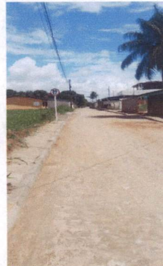
Descrição: RUA DOIS (CHÃ DE CONSELHO) – 30.3.1 FORNECIMENTO E IMPLANTAÇÃO DE REGULAMENTAÇÃO EM AÇO D = 0,60 M – PELÍCULA RETRORREFLETIVA TIPO I E SI
