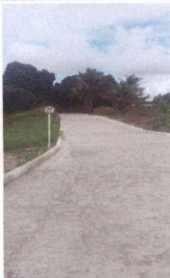
Descrição: RUA DOIS (CHÃ DE CONSELHO) – 30.3.2 FORNECIMENTO E IMPLANTAÇÃO DE REGULAMENTAÇÃO EM AÇO D = 0,60 M – PELÍCULA RETRORREFLETIVA TIPO I E SI
