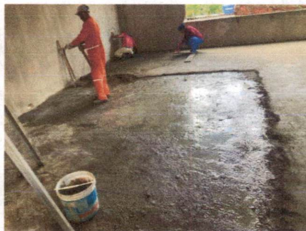
Foto 2: Contrapiso em argamassa traço 1:4 (cimento e areia), aplicado em áreas secas sobre laje, espessura 5 cm. (Item 9.1.2)
