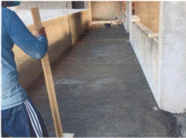
Foto 5: Contrapiso em argamassa traço 1:4 (cimento e areia), aplicado em áreas secas sobre laje, espessura 5 cm. (Item 9.1.2)
