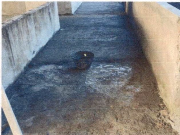
Foto 4: Contrapiso em argamassa traço 1:4 (cimento e areia), aplicado em áreas secas sobre laje, espessura 5 cm. (Item 9.1.2)
