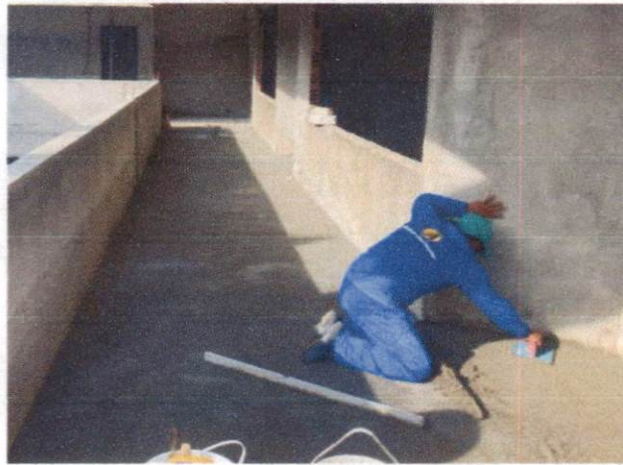
Foto 7: Contrapiso em argamassa traço 1:4 (cimento e areia), aplicado em áreas secas sobre laje, espessura 5 cm. (Item 9.1.2)
