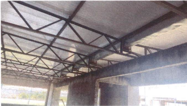
Foto 1: Calha em chapa metalizada (Item 7.4)
