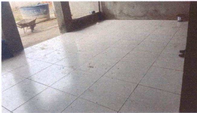
Foto 5: Aplicação de cerâmica no Hall do Bloco A (Item 10.1.6)
