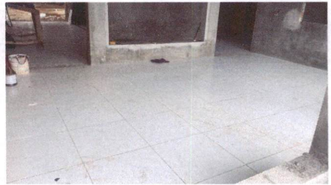
Foto 6: Aplicação de cerâmica no Hall do Bloco A (Item 10.1.6)
