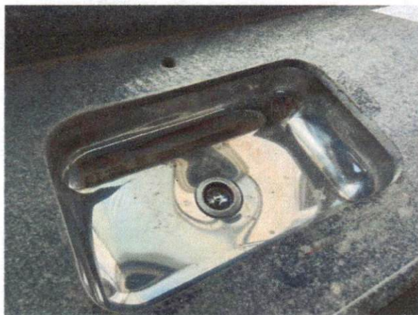
Foto 17: Cuba de embutir de aço inoxidável, incluso válvula tipo americana em metal cromado e sifão flexível em PVC, fornecimento e instalação (Item 11.12)
