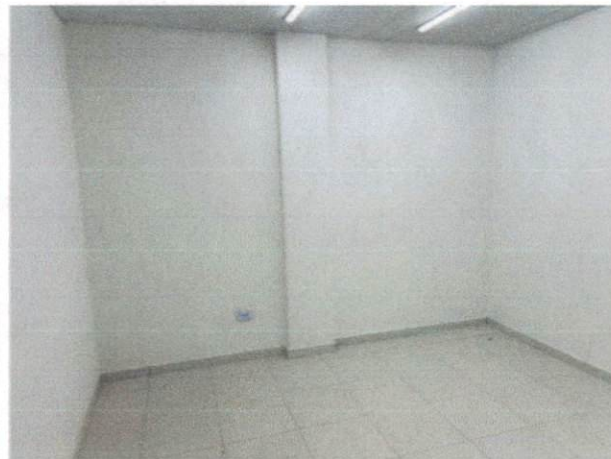
Foto 2: Aplicação manual de pintura com tinta látex PVA em paredes, duas demãos. (Item 9.3)
