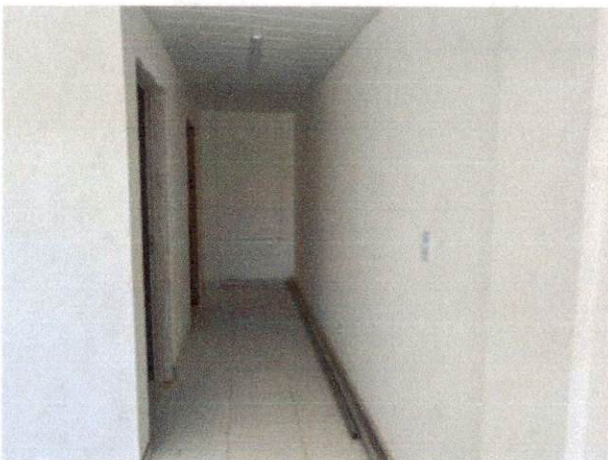
Foto 7: Aplicação manual de pintura com tinta látex PVA em paredes, duas demãos. (Item 9.3)
