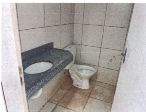
Foto 16: Fornecimento e assentamento de cuba de embutir, oval, de louça branca. (Item 11.11)
