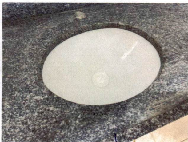
Foto 15: Fornecimento e assentamento de cuba de embutir, oval, de louça branca. (Item 11.11)
