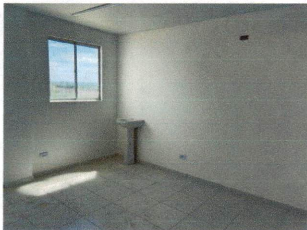
Foto 5: Aplicação manual de pintura com tinta látex PVA em paredes, duas demãos. (Item 9.3)
