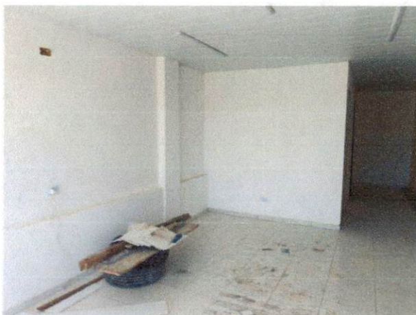
Foto 8: Aplicação manual de pintura com tinta látex PVA em paredes, duas demãos. (Item 9.3)
