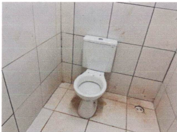
Foto 13: Fornecimento e assentamento de bacia sanitária com caixa acoplada, louça branca. (Item 11.7)
