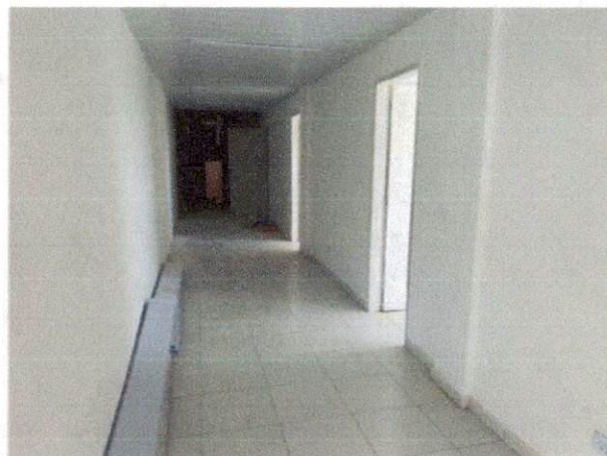
Foto 6: Aplicação manual de pintura com tinta látex PVA em paredes, duas demãos. (Item 9.3)
