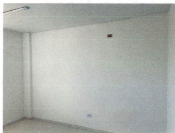
Foto 4: Aplicação manual de pintura com tinta látex PVA em paredes, duas demãos. (Item 9.3)
