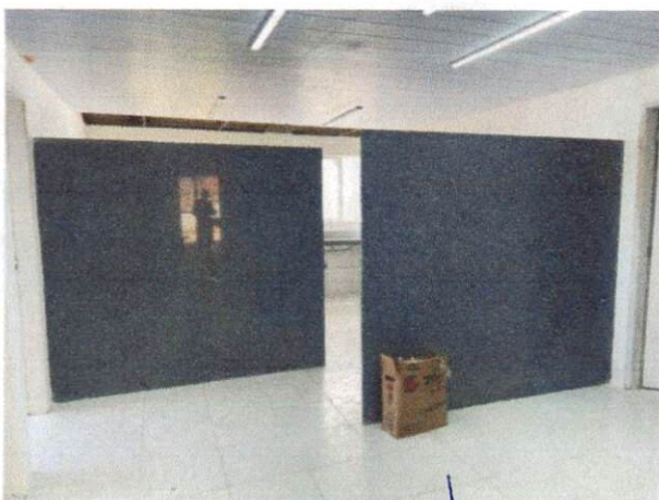
Foto 19: Divisória de granito natural polido nos dois lados cinza andorinha com 2 cm de espessura, inclusive transporte, montagem e assentamento. (Item 12.1)
