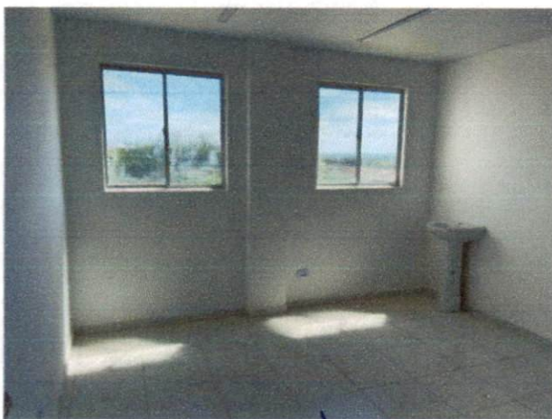
Foto 3: Aplicação manual de pintura com tinta látex PVA em paredes, duas demãos. (Item 9.3)
