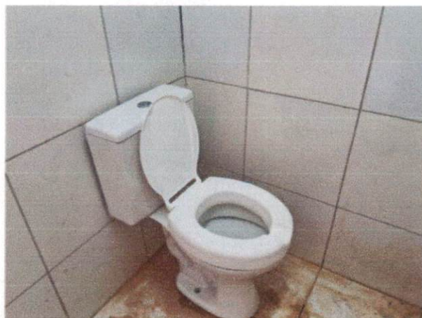
Foto 14: Vaso sanitário sifonado convencional para PCD com louça branca, incluso conjunto de ligação. (Item 11.8)
