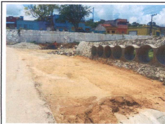
Descrição: TUBO DE CONCRETO PARA REDES COLETORAS DE ÁGUAS PLUVIAIS, DIÂMETRO DE 1000 MM, JUNTA RÍGIDA, INSTALADO EM LOCAL COM ALTO NÍVEL DE INTERFERÊNCIAS
