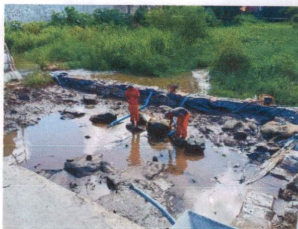
Descrição: ENSECADEIRA COM EMPREGO DE SACOS DE BARRO PARA ATERRO
