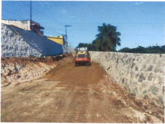
Descrição: EXECUÇÃO E COMPACTAÇÃO DE BASE E OU SUB-BASE PARA PAVIMENTAÇÃO DE SOLO (PREDOMINANTEMENTE ARENOSO) COM CIMENTO (TEOR DE 8%)
