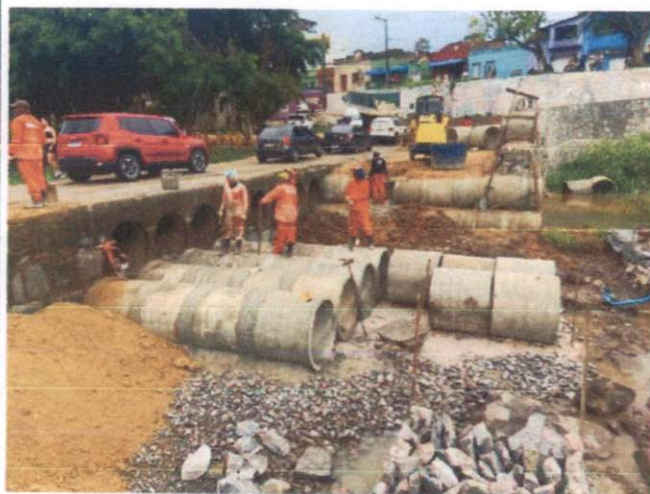
Descrição: TUBO DE CONCRETO PARA REDES COLETORAS DE ÁGUAS PLUVIAIS, DIÂMETRO DE 1000 MM, JUNTA RÍGIDA, INSTALADO EM LOCAL COM ALTO NÍVEL DE INTERFERÊNCIAS
