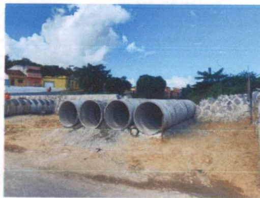
Descrição: TUBO DE CONCRETO PARA REDES COLETORAS DE ÁGUAS PLUVIAIS, DIÂMETRO DE 1000 MM, JUNTA RÍGIDA, INSTALADO EM LOCAL COM ALTO NÍVEL DE INTERFERÊNCIAS
