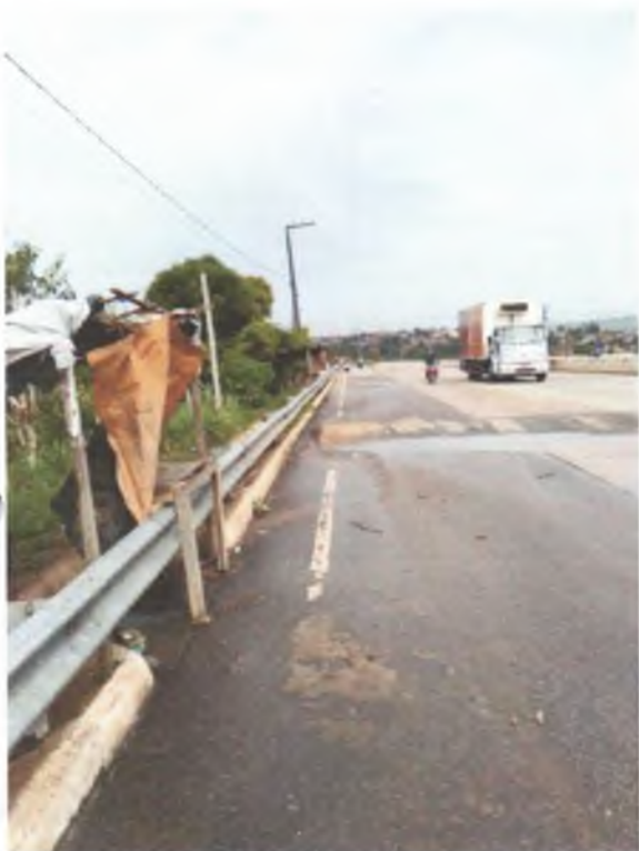
BR 408, após à lombada física Sentido Recife
